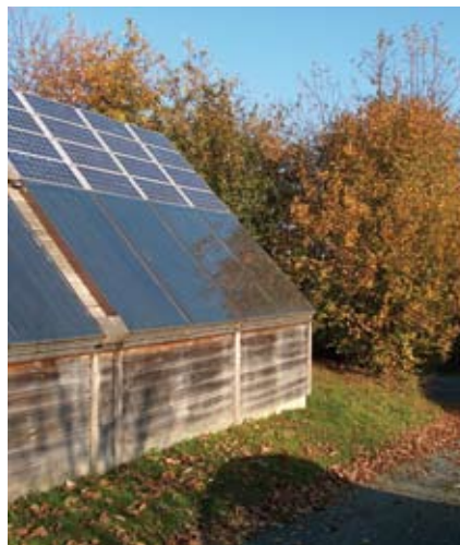
Les capteurs solaires s'intègrent sur la totalité du pan de toiture
