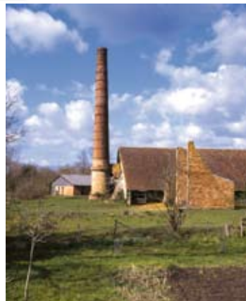
Les anciennes tuileries et briqueteries témoignent de l'utilisation des ressources du sol du Marais poitevin
