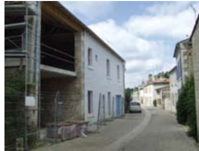
La nouvelle construction s'implante dans l'alignement des bâtiments existants et participe ainsi à qualifier la rue
