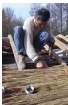
Pose de roseaux sous une toiture traditionnelle
