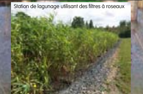
Station de lagunage utilisant des filtres à roseaux
