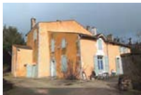
Vallans. Exemple de logements aménagés dans du bâti ancien respectueux du patrimoine.
