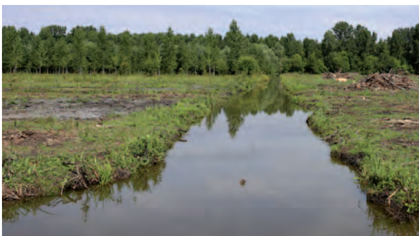
Le réseau secondaire est curé lors des travaux forestiers, les boues extraites permettant de réhausser le bourrelet de rives.
