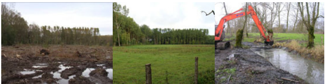
Parcelle sur Arçais, avant travaux,
