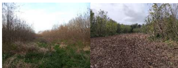
Parcelle de Arçais avant travaux (à gauche) et après travaux (à droite)
