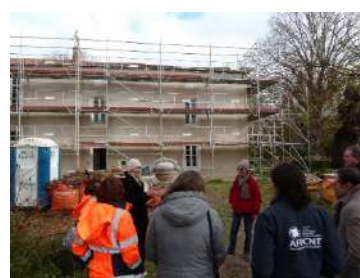
Visite d'un chantier lors de la journée d'étude Résilience Tour 19 nov. 2025
