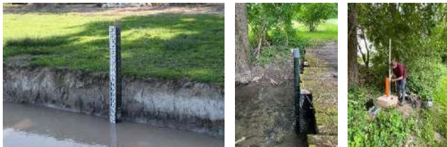
3 des 9 stations de mesure de niveaux d'eau installées sur le site du Vendié
