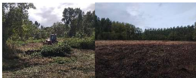
Travaux de broyage au Vanneau-Irleau (à gauche) et parcelle du Vanneau-Irleau après travaux (à droite)
