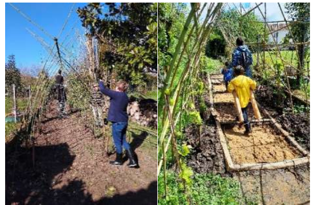
Chantier participatif de création d'une arche en bambou (à gauche) et d'un chemin sensoriel (à droite) à Magné
