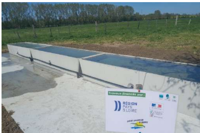
Abreuvoir installé sur le marais communal de Saint-Sauveur-d'Aunis
