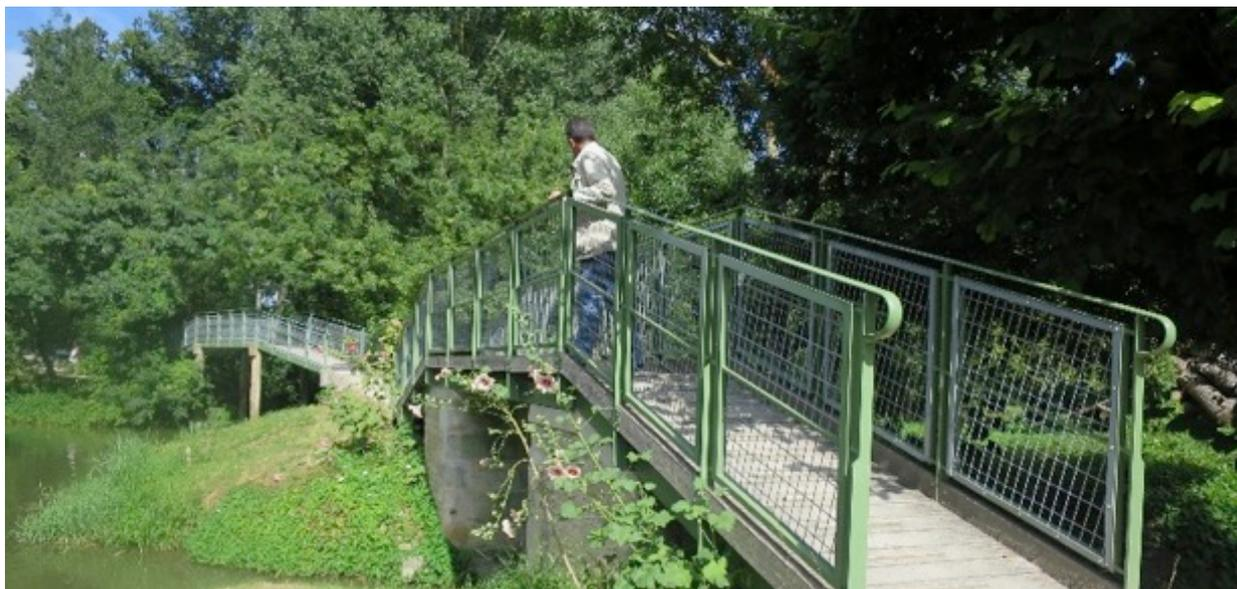
Côté Deux-Sèvres, dans le même esprit, trois passerelles piétonnes en mauvais état ont été remplacées par des ouvrages neufs et un soin particulier a été porté aux dessins des garde-corps, aux matériaux employés pour le tablier et les culées supportant ces ouvrages. La commune, maître d'ouvrage, a conduit ce projet en lien avec le Parc et l'État, pour concilier normes en matière d'accueil du public et insertion paysagère et architecturale. Les travaux ont été menés en 2012.
