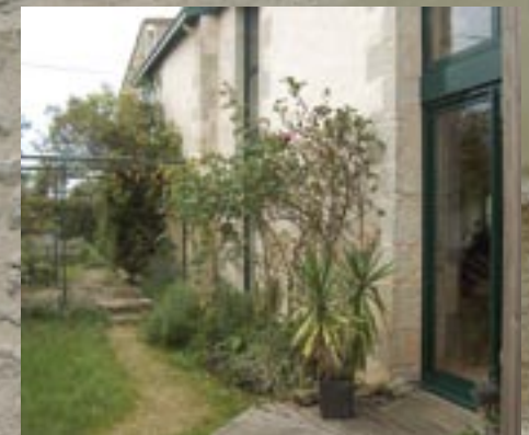
Réhabilitation : les volumes ont été ajourés (baies vitrées), ou fermés (bardage bois vers le jardin) Architecte : Jeannick Lamy, Saint-Georges-de-Rex
