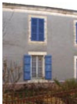
Enduit, volets, menuiseries et même soubassement et encadrement... chaque élément porte une couleur.
