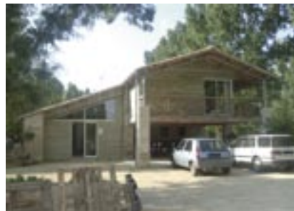
Réhabilitation d'une architecture traditionnelle en gîte
