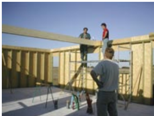
Montage d'une maison à ossature bois
