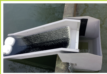
Passer à Anguilles équipée de flotteurs pour suivre les variations du niveau d'eau.
