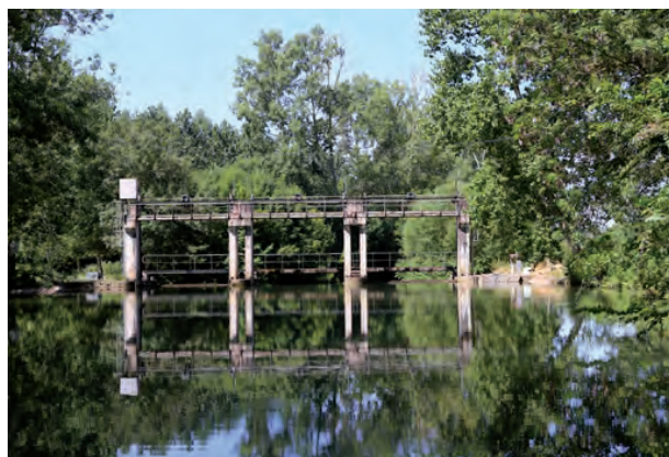
Ouvrage de régulation des niveaux d'eau à Sevreau
