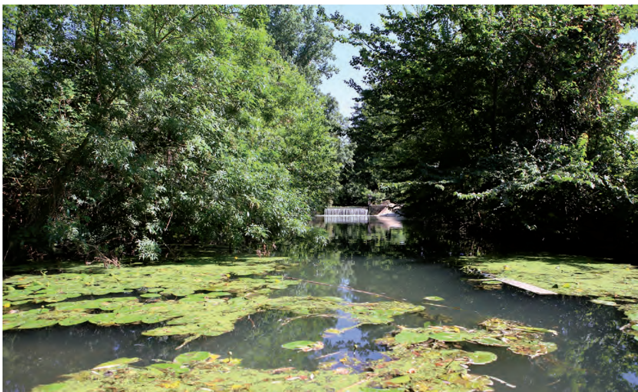
Seuil en limite supérieure du casier du marais de Bessines et de l'Ouchette
