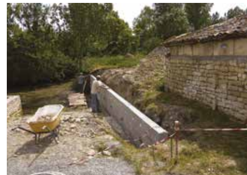
Port de la Trigalle | PENDANT ET APRÈS TRAVAUX
