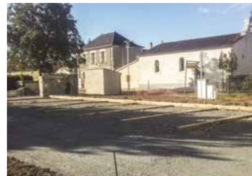
Aire de stationnement | PENDANT ET APRÈS TRAVAUX
