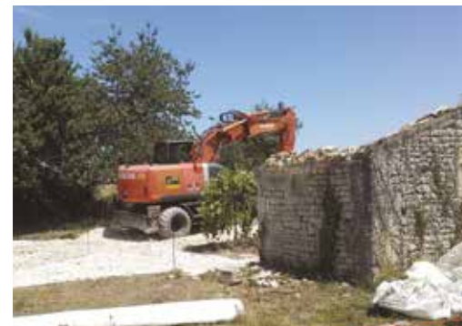
Aire de stationnement | PENDANT ET APRÈS TRAVAUX
