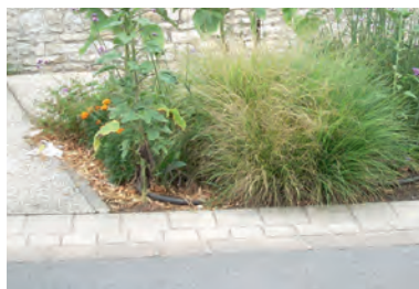
A Vouillé-les-Marais, le caniveau est une alternative à la bordure et délimite sobrement les massifs tout en facilitant leur entretien. En remplaçant les trottoirs par une bordure à hauteur de la route, vous faciliterez également l'accessibilité aux personnes à mobilité réduite.
