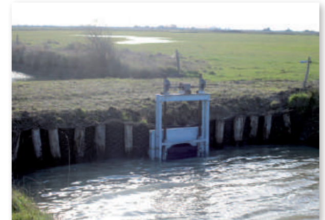
Restauration d'un ouvrage hydraulique
