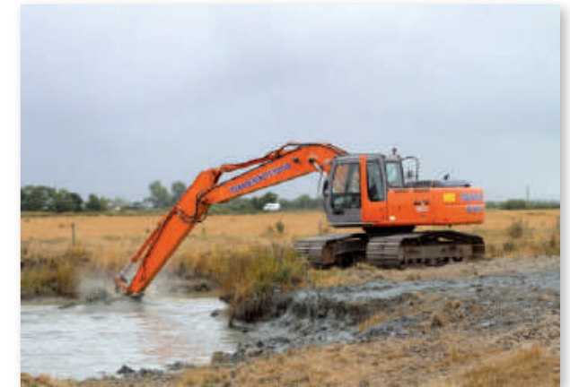
Opération de curage du réseau hydraulique
