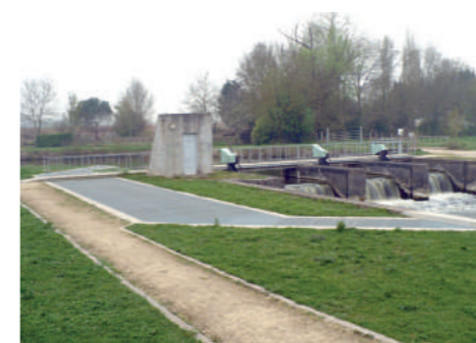
Barrage du Marais Pin
