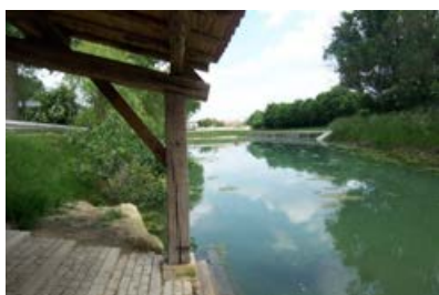
Réhabilitation du port d'Aziré à Benet (2010).
