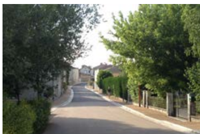
Aménagement de la rue du port au Mazeau (2015-2016).
