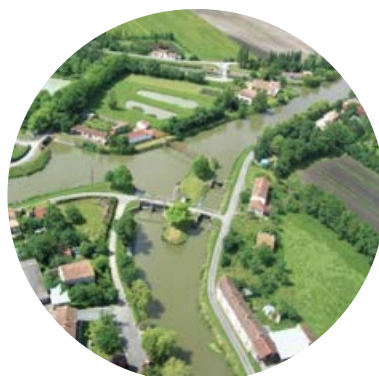
Réseau hydraulique 2000 km de voies d'eau dans le site classé
