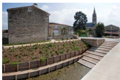
L'impasse et le port de La Gachère à Saint-Hilaire-La-Palud (2009).
