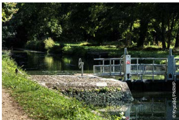
L'écluse rénovée de la Tiffardière, à Niort.
