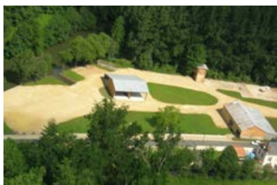
Réhabilitation de l'ancienne scierie de la Garett à Magné (2007).
