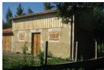
Réhabilitation de l'ancienne Maison éclusière des Bourdettes (Arçais/Damvix – 2013-2014).
