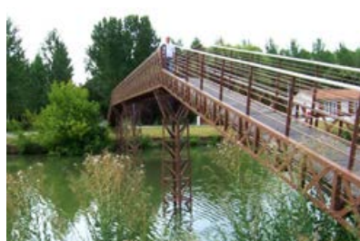
Restauration de la passerelle du Village de la Sèvre reliant les 2 régions (2008).
