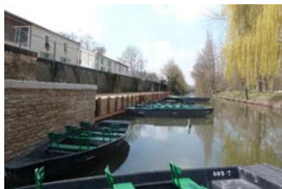
Réhabilitation des quais et du pont d'Arçais (2012).
