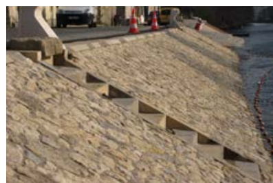
Consolidation et embellissement des quais de Coulon (2011).
