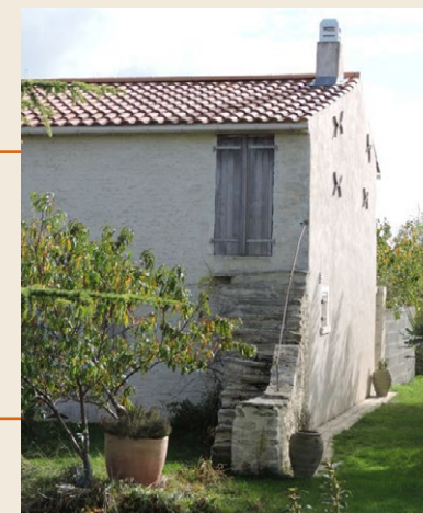
Dans certains secteurs, on repère des escaliers extérieurs assez rares cependant, ici à Sainte-Radégonde-des-Noyers (85).
