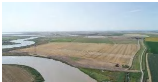
Avant travaux- 21 juillet 2020 (photo RNN Baie Aiguillon)
