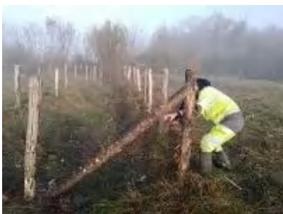
Remplacement des piquets d'angle
