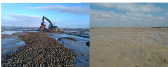
Avant et après travaux
