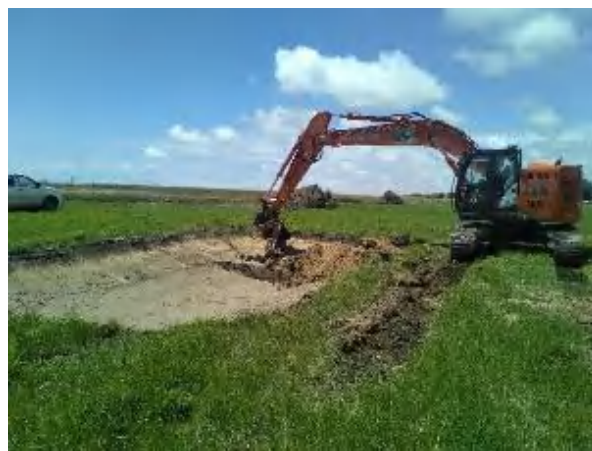
Travaux de creusement d'une des deux mares
