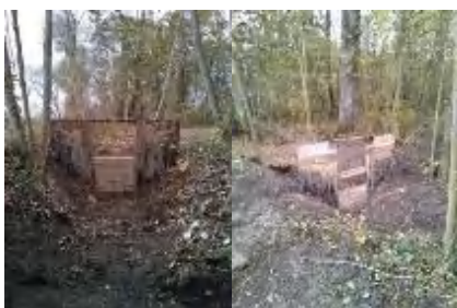
2 ouvrages hydrauliques posés équipés de madriers
