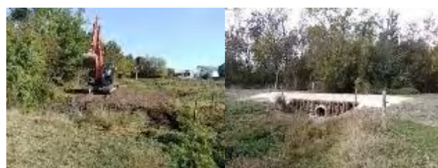
Création d'un passage busé fonctionnel tant pour les bovins que pour l'eau.
