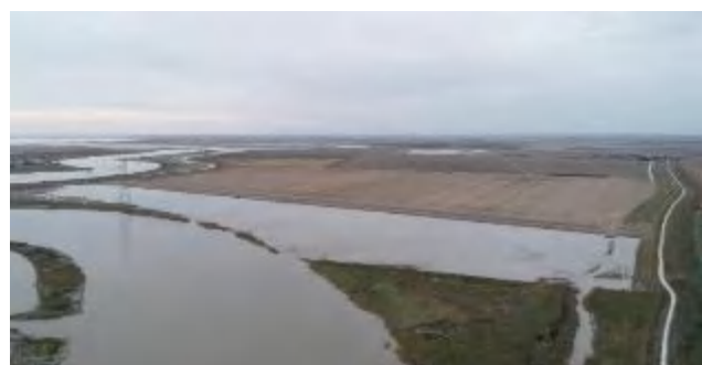
Après travaux- 18 septembre 2020 (photo RNN Baie Aiguillon)
