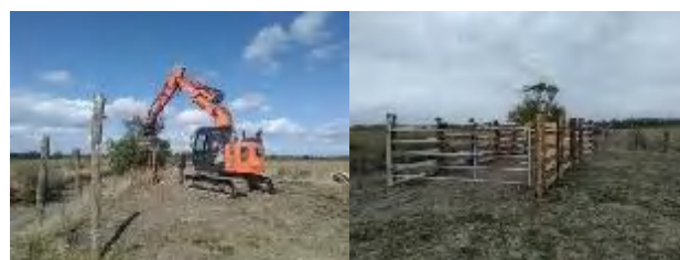
Démontage et évacuation de l'ancien aménagement et parc de contention restauré équipé de deux barrières (Les Magnils-Reigniers)
